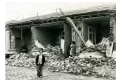
Terremoto de Valdivia. Casas habitación destruidas por la fuerza del terremoto. (Fotografía Archivo Museo Histórico Nacional)
