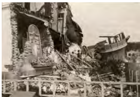
Terremoto de 1906. Vista de las ruinas de una casa en la población Vergara de Viña del Mar, tras el terremoto de 1906. Región de Valparaíso. (Fotografía Archivo Museo Histórico Nacional)
